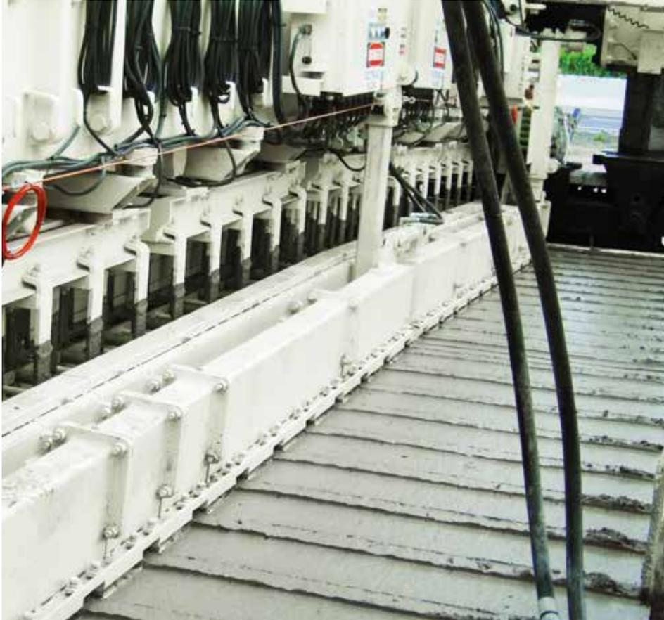
El DBI de G&Z está comprobado en el campo y cuenta con gran precisión. Su diseño modular facilita el cambio de ancho y el transporte.
